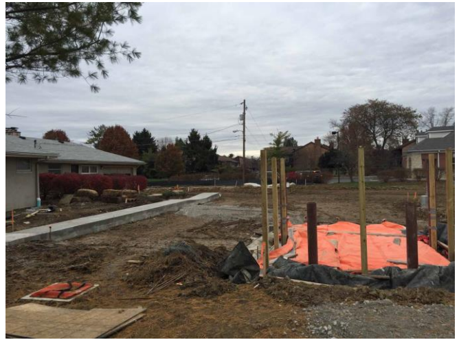
圖 56: 11/12 由 5038 往北看 5054 的後面，圖中正在建 Dumpster Pad，原 5038 的大型垃圾桶將移至這裡。
