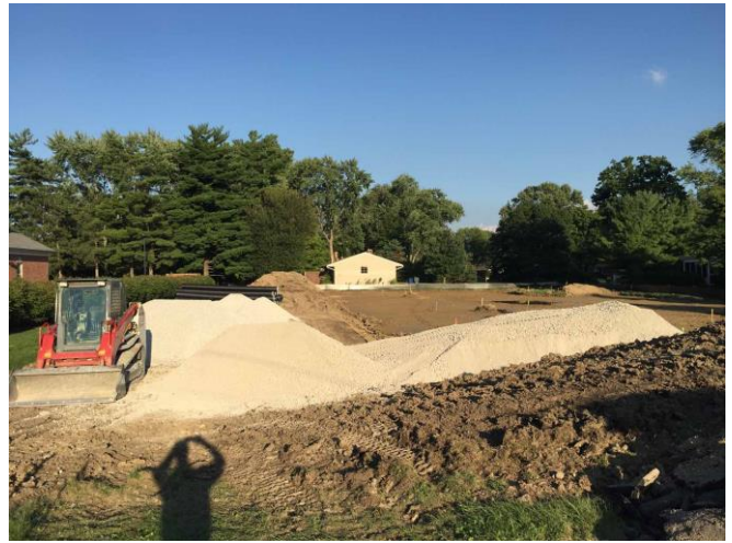
圖 51: 9/13 由 5054 向後望, 充滿了所挖土方及 施工的土、石頭及管線材料
