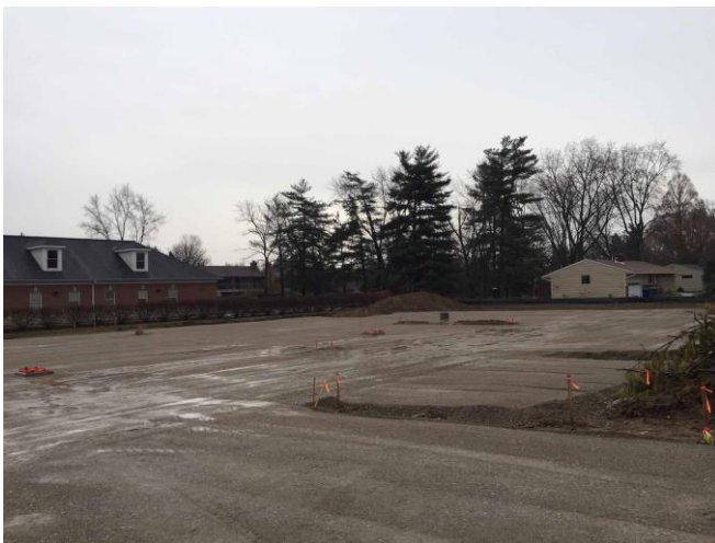
圖 57: 12/15 停車場地坪鋪面工程完工前的碎石已經鋪好，可惜天氣不好（降雨），已經冬天了，所以瀝青柏油今年無法完成，要延到明年（2019 年）。
