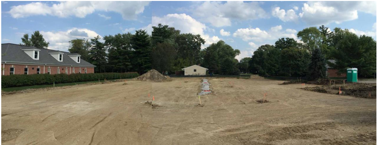
圖 52: 9/22 由 5054 往後看, 這整片就是最主要的 (教堂後方) 的停車場, 整地大致完成, 尚未照明及地坪鋪面工程。
