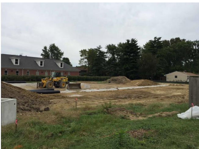
圖 53: 9/22 由 5038 向 5054 的東北角看, 已開始地下管線的施工
