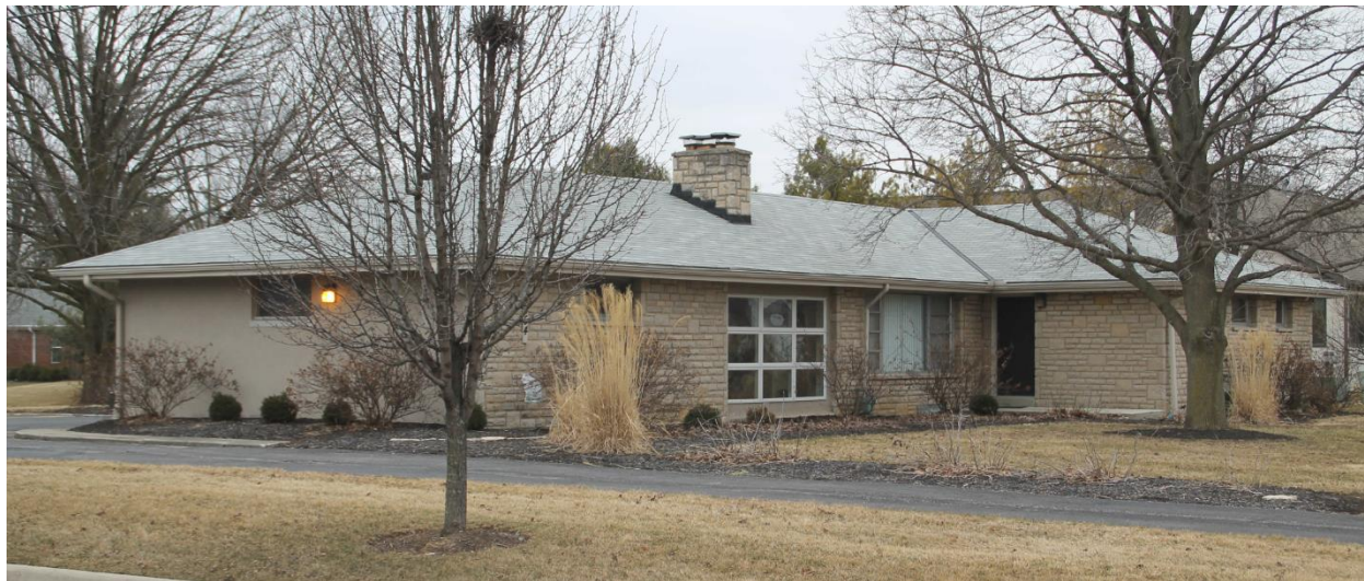
圖 21: 5054 Reed Road 建築
