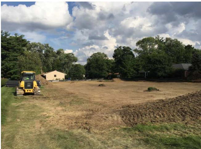
圖 48: 2018/8/27 正式動工，開始挖土整地，由 5054 往東南看
