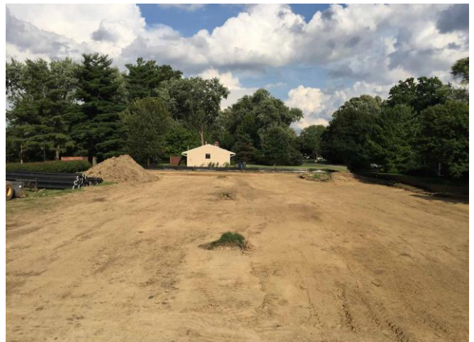
圖 49: 2018/8/27 挖土整地，由 5054 向後望
